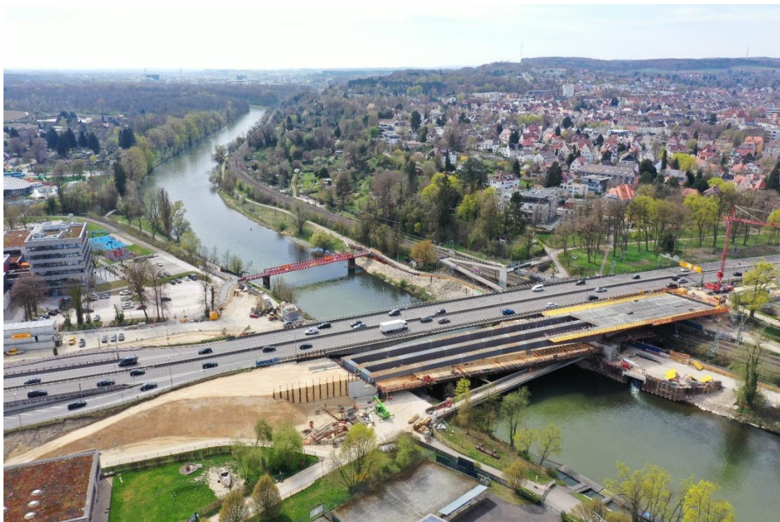
Adenauerbrücke (Copyright: Staatliches Bauamt Krumbach)
