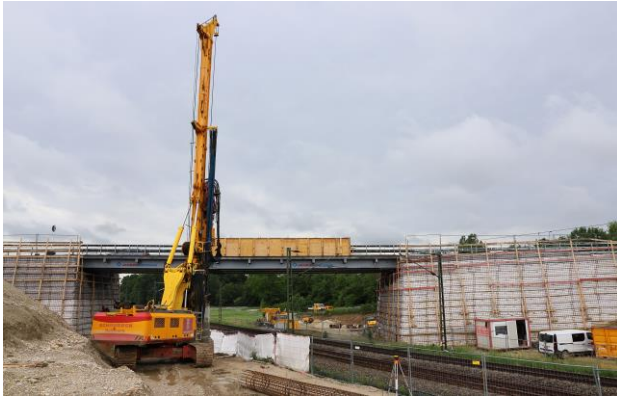
Abb.: Arbeiten an der Tiefgründung für den Ersatzneubau
