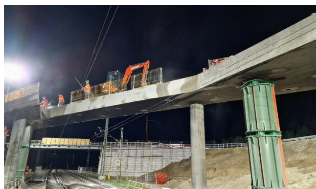
Abb.: Bestandsbauwerk nach Aushub Mittelfeld
