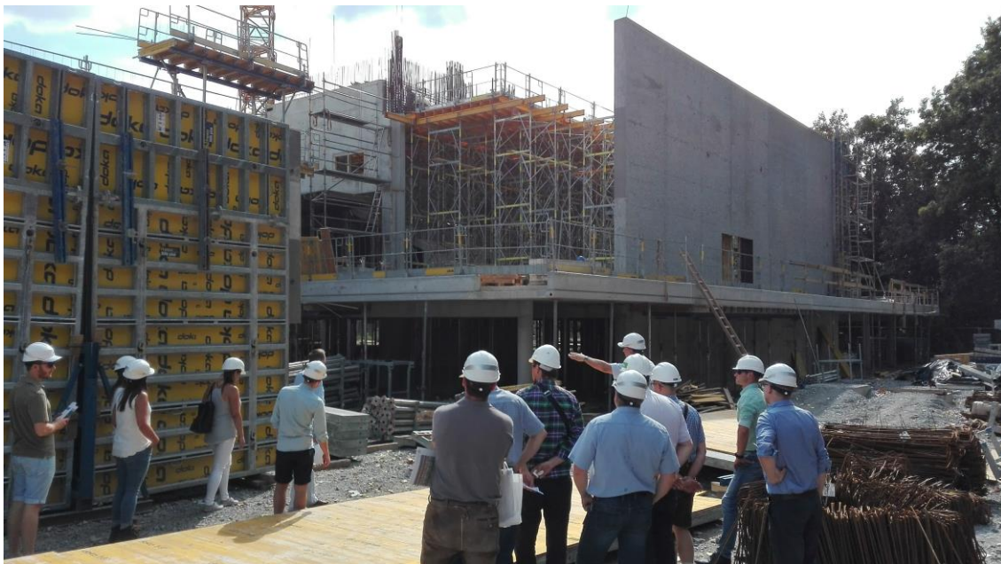
Besichtigung der Betonbauarbeiten der Nachhaltigen Chemie
