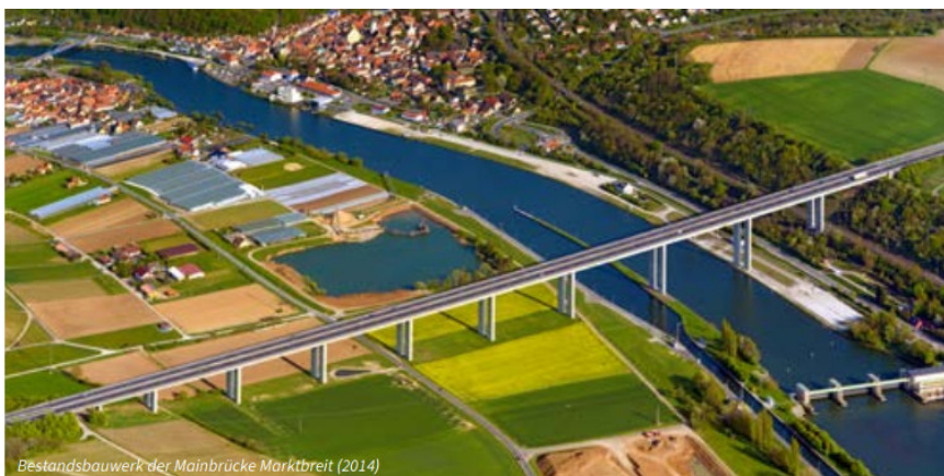
Bestandsbauwerk der Mainbrücke Marktbreit (2014)
